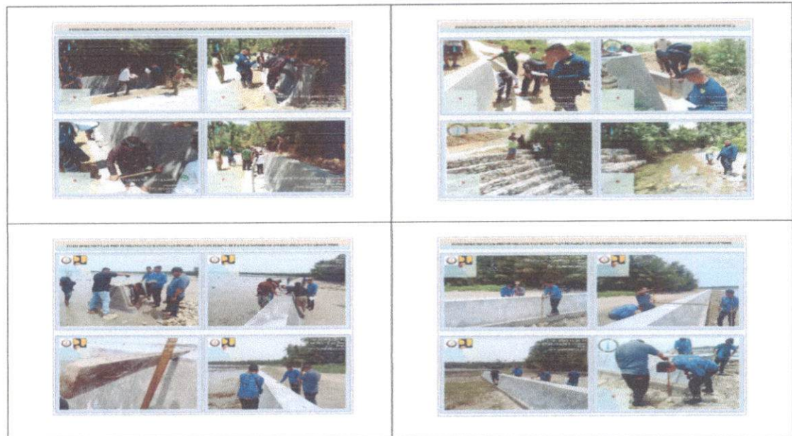
Gambar 3.3 Pembangunan Tembok Penahan Tanah 2025
