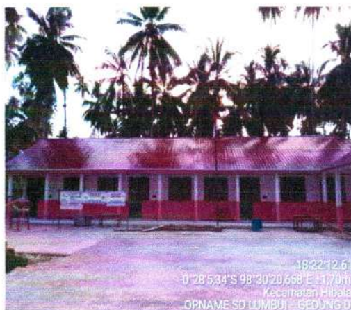
Pembangunan Ruang Kelas SD Negeri 071125 Lumbui
