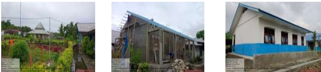
Keterangan : Pembangunan Gedung Laboratorium SMP
